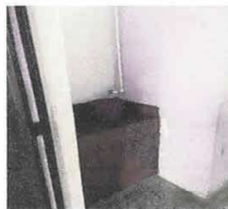
Foto 6: Trabajo para instalación de lavamanos
