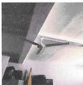
Foto 5: trabajos para instalación de ventiladores
