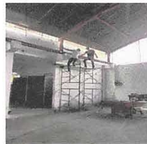
Foto 2: Trabajo para instalación de canales
