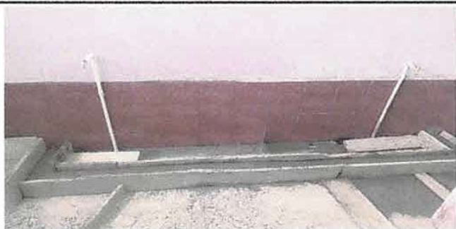
Foto1: Trabajo para la instalación de pilas
